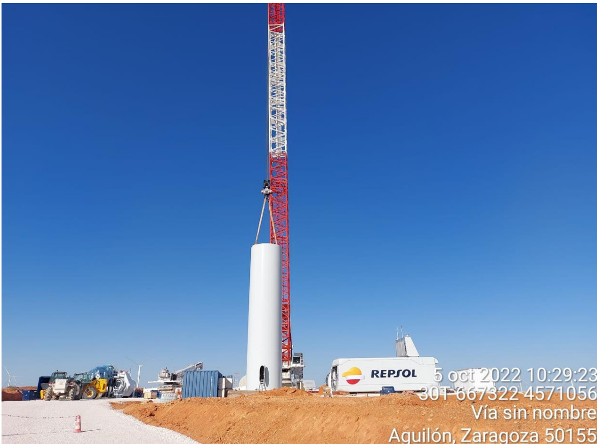
Imagen 4. Grúa colocando T1 en PLX-02.
